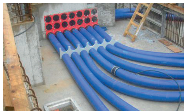
Kabeleinführungssystem KES-M150 mit Abstandhalter zur Fixierung und Positionierung der Schlauchpakete.
