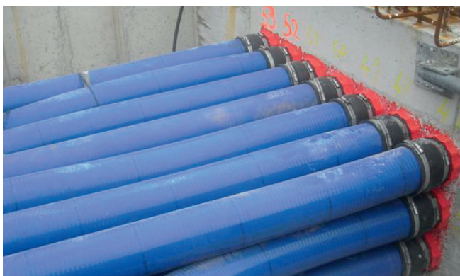
Kabeleinführungssystem KES-M150 mit druckwasserdichtem Anschluß an die einbetonierten Dichtpackungen HSI 150-K2.
