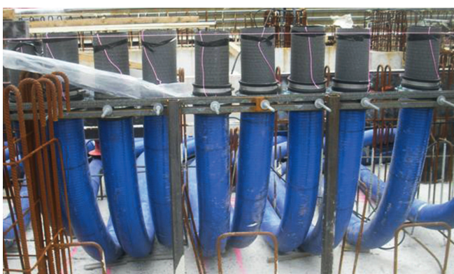
Maßgenaue Ausrichtung der Kabeleinführungssysteme KES-M150 und Rohrstützen an der Oberkante-Fertigfußboden (OKFF). Eine exakte Anpassung auf OKFF ist durch Ablängung der Rohrstützen möglich.
