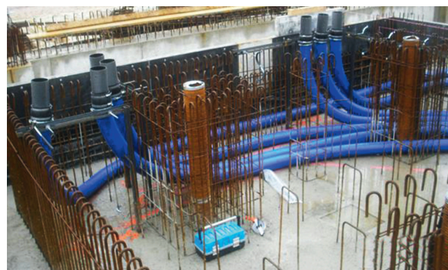
Kabeleinführungssystem KES-M150 als druckwasserdichte und flexible Durchführung durch die Bodenplatte.
